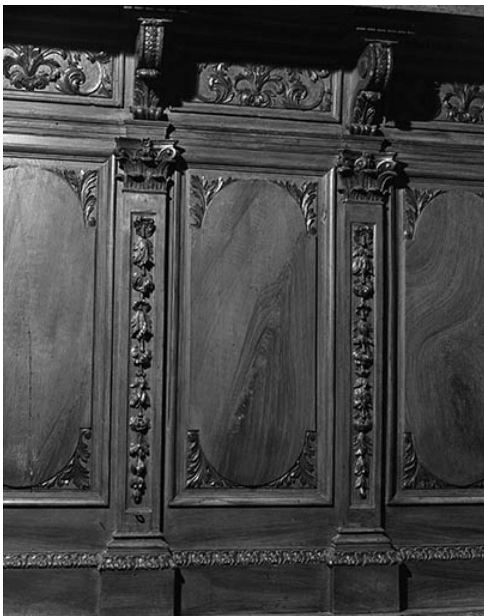
Vue d'un panneau des lambris de demi-revêtement.
