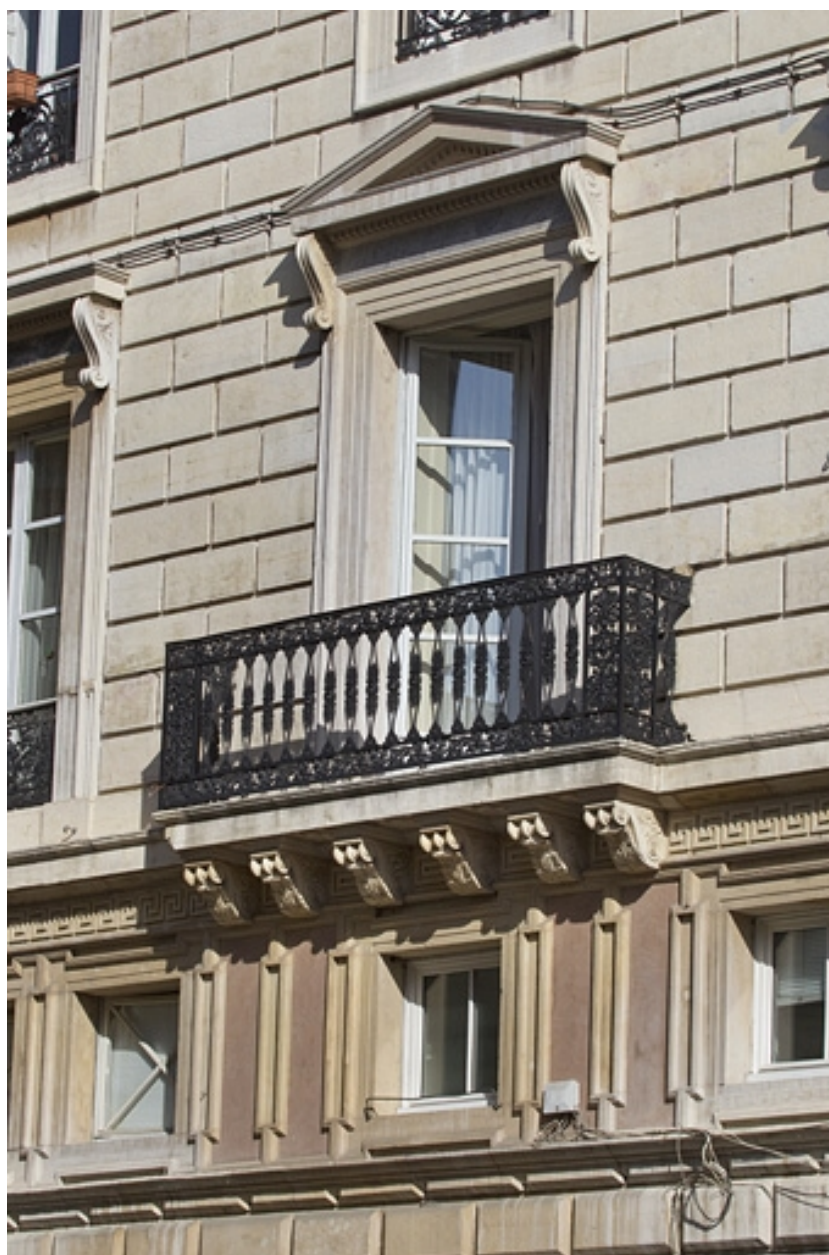
Façade latérale droite : détail du balcon.
