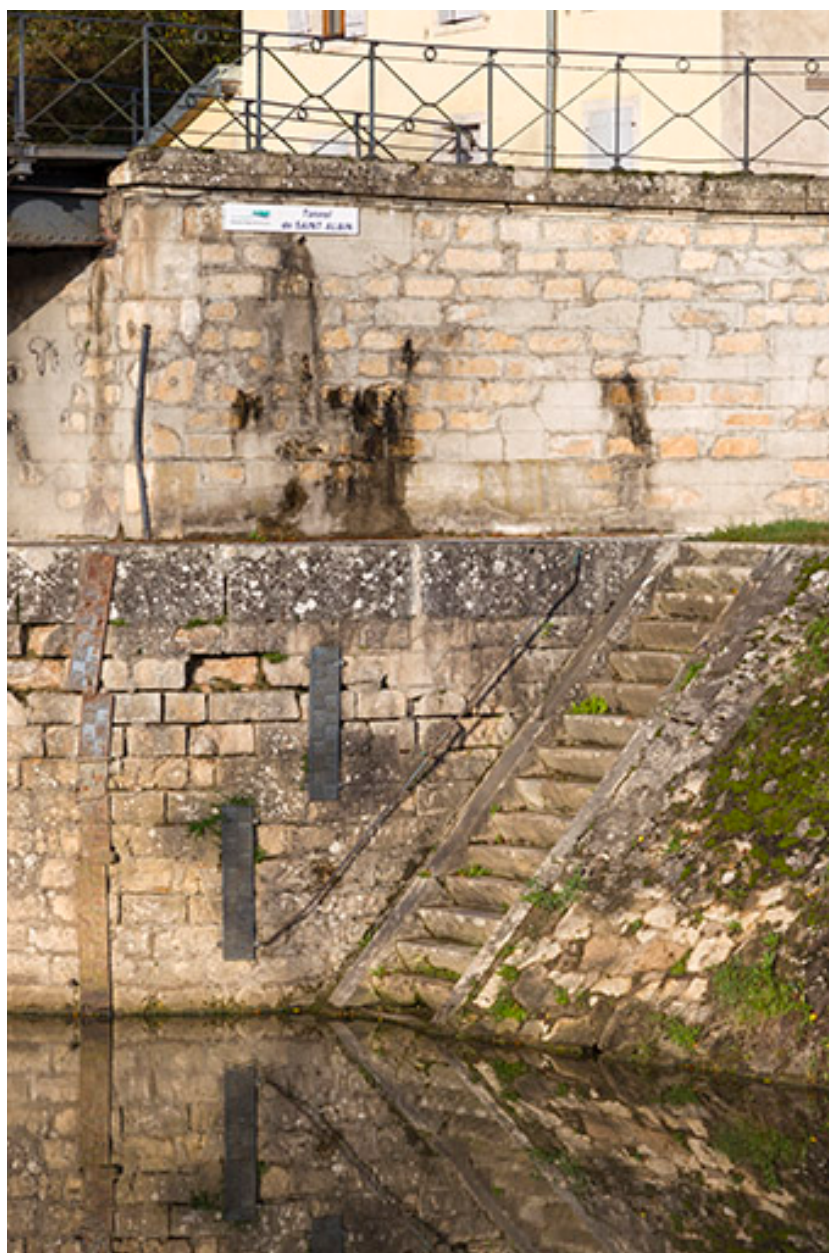
Détail de la maçonnerie.
