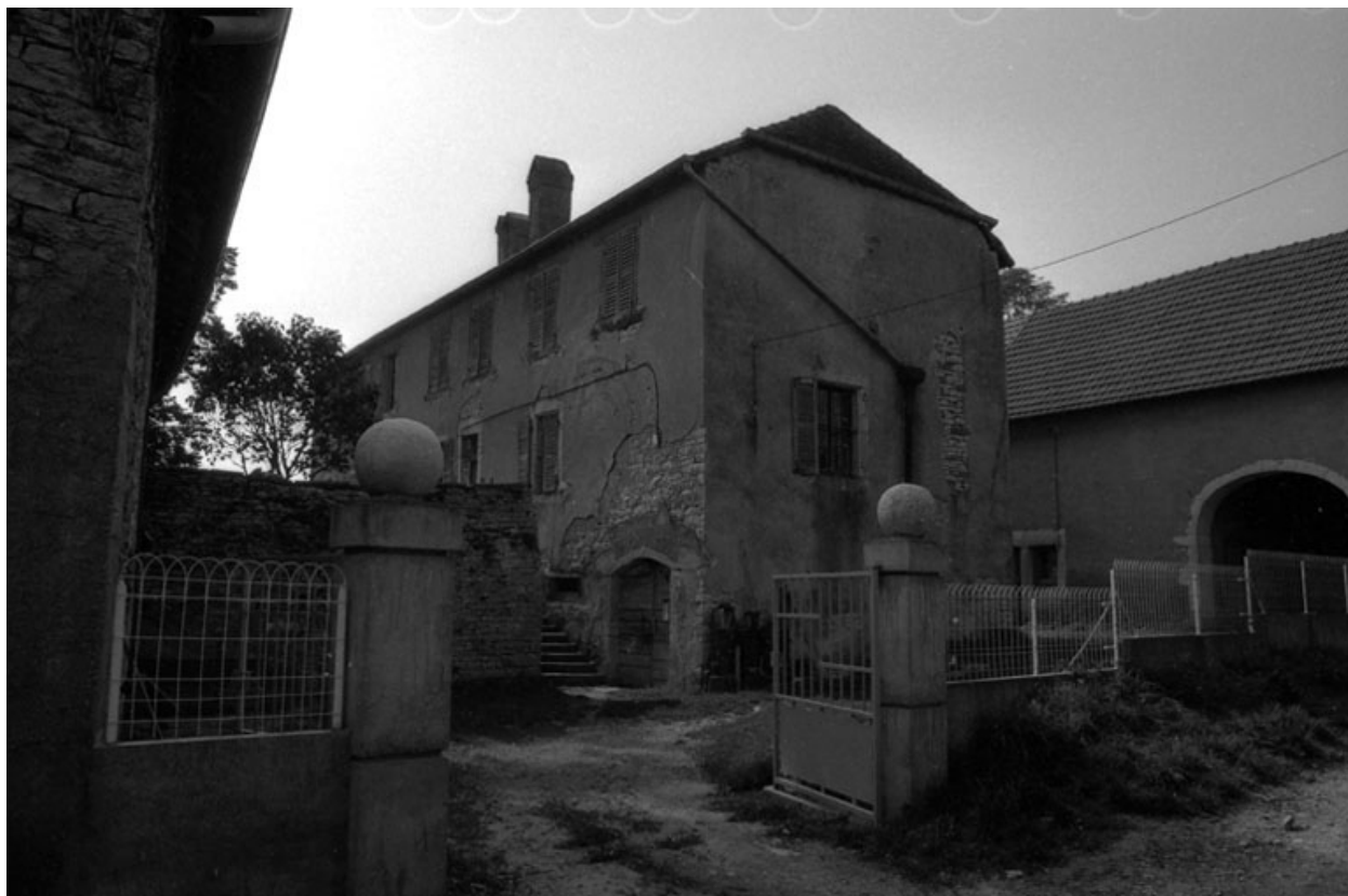
Maison d'habitation : façades antérieure et latérale droite.
