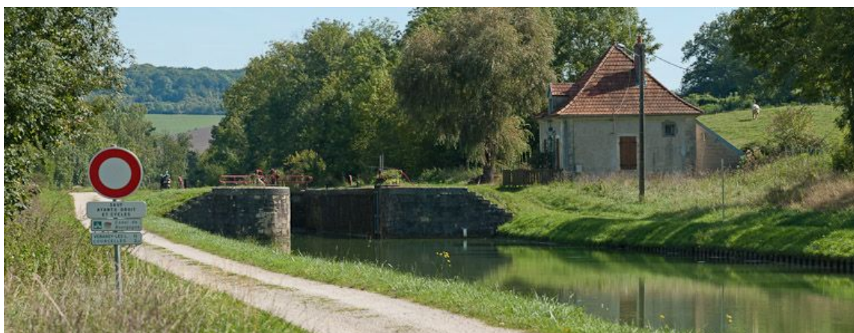
Vue du site d'écluse depuis l'amont.
