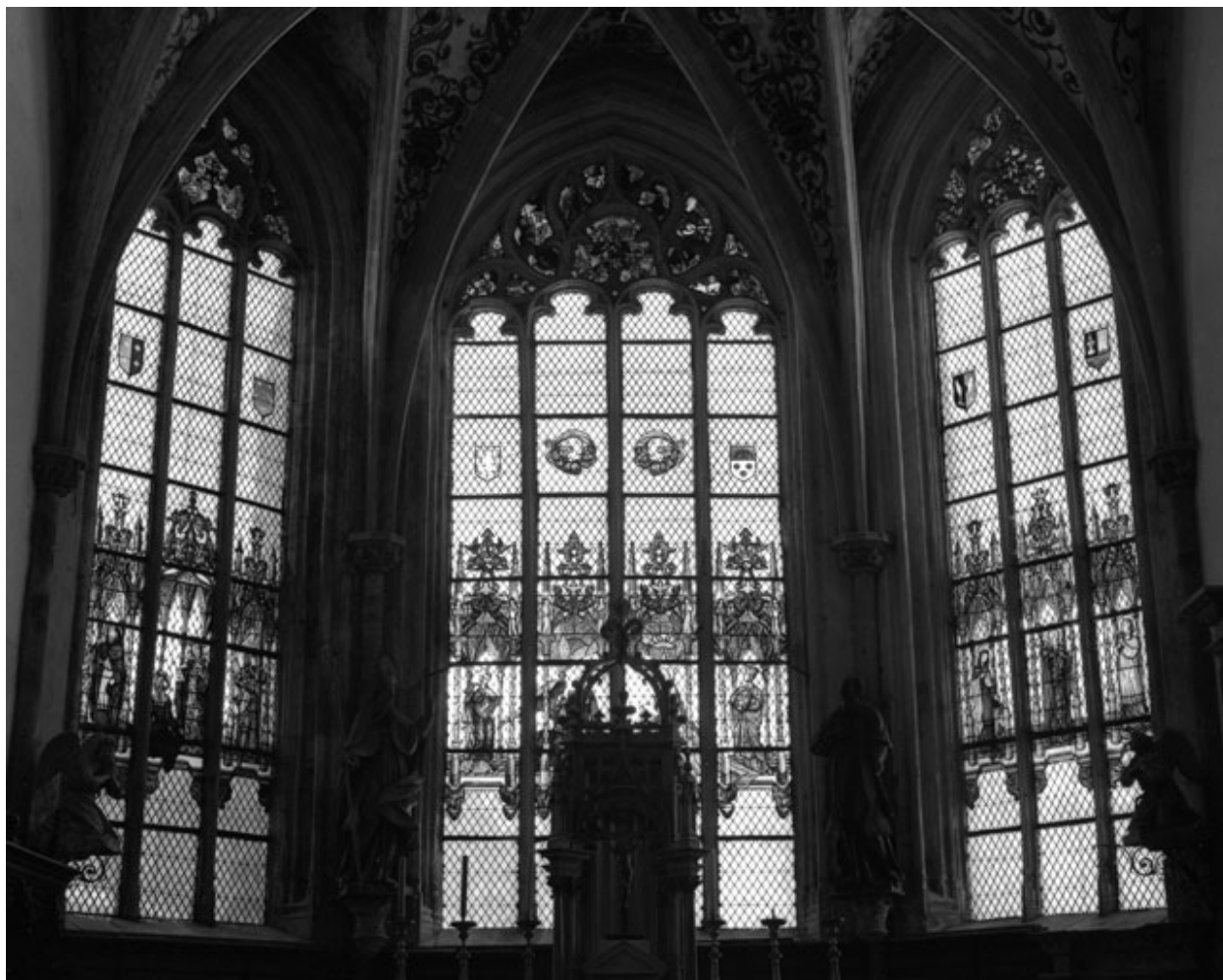
Vue d'ensemble des baies du chœur.
