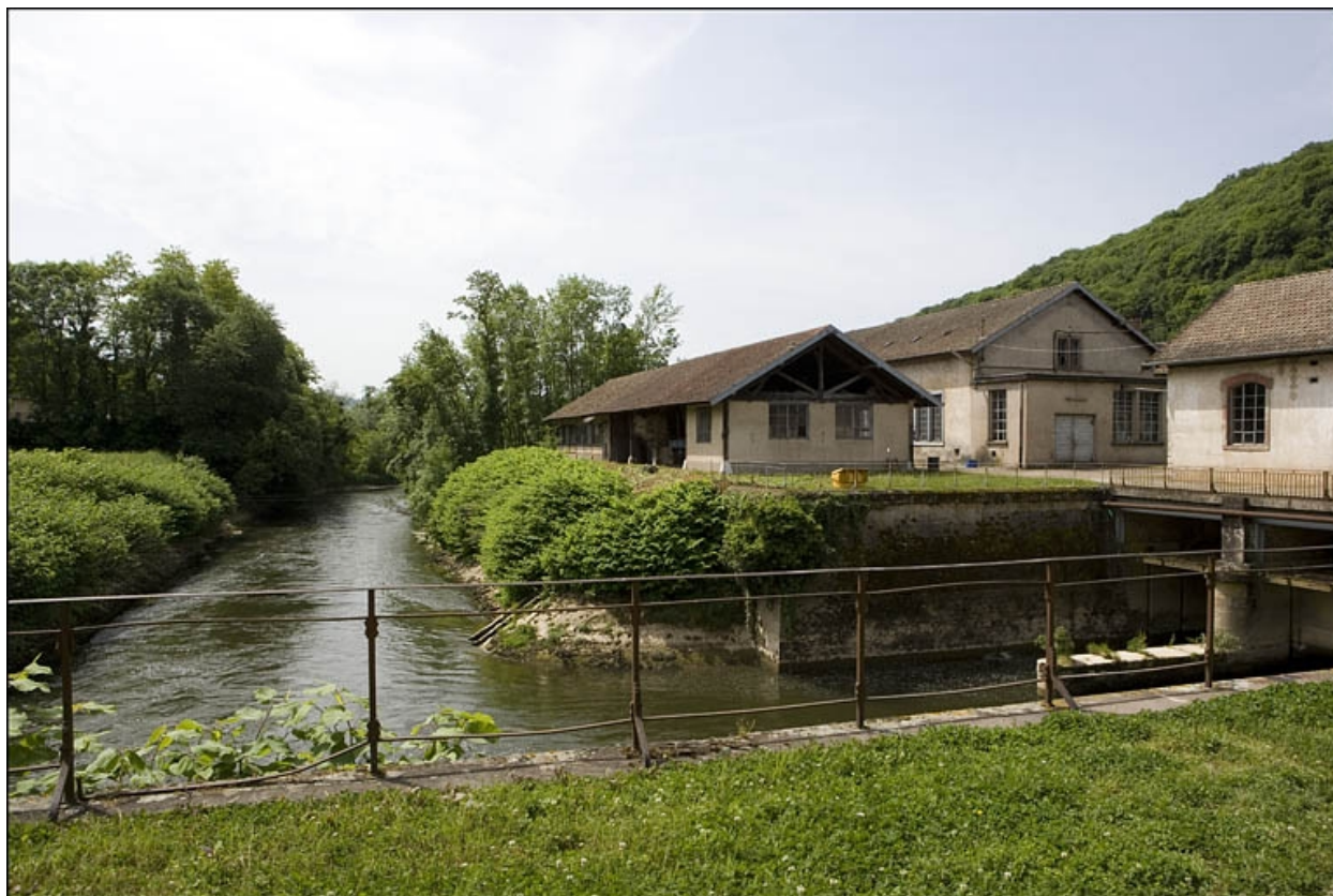
Bief de dérivation et hangar industriel.
