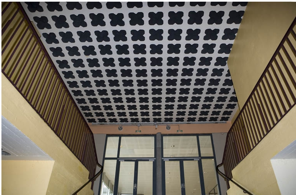
Bâtiment B. Détail plafond.
