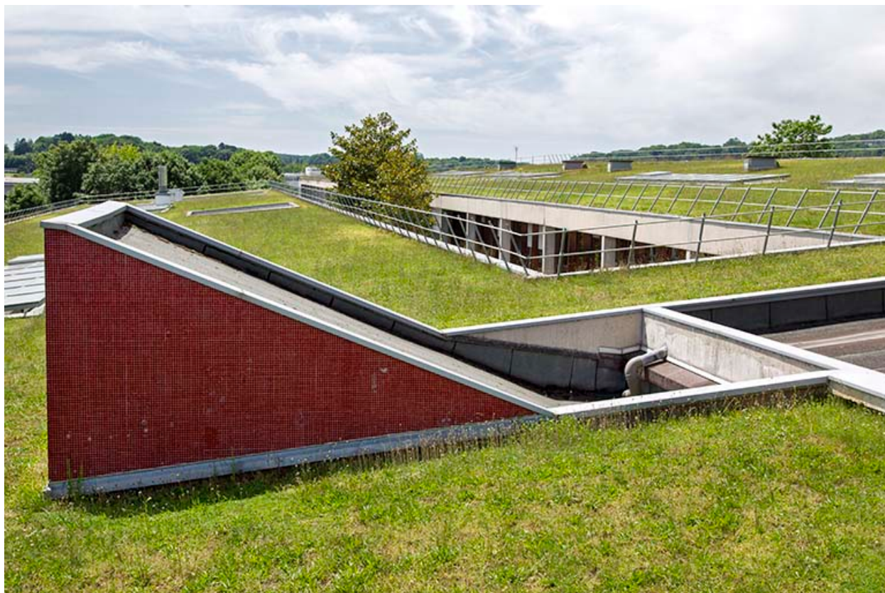
Détail de lucarne sur la terrasse.
