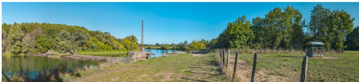
Vue d'ensemble du barrage en 2019.
