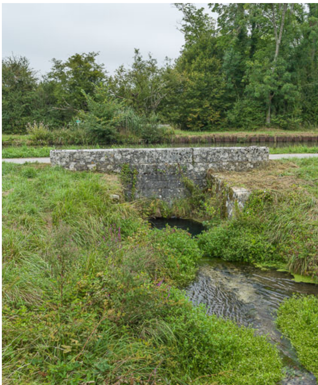
Vue de l'aqueduc.
