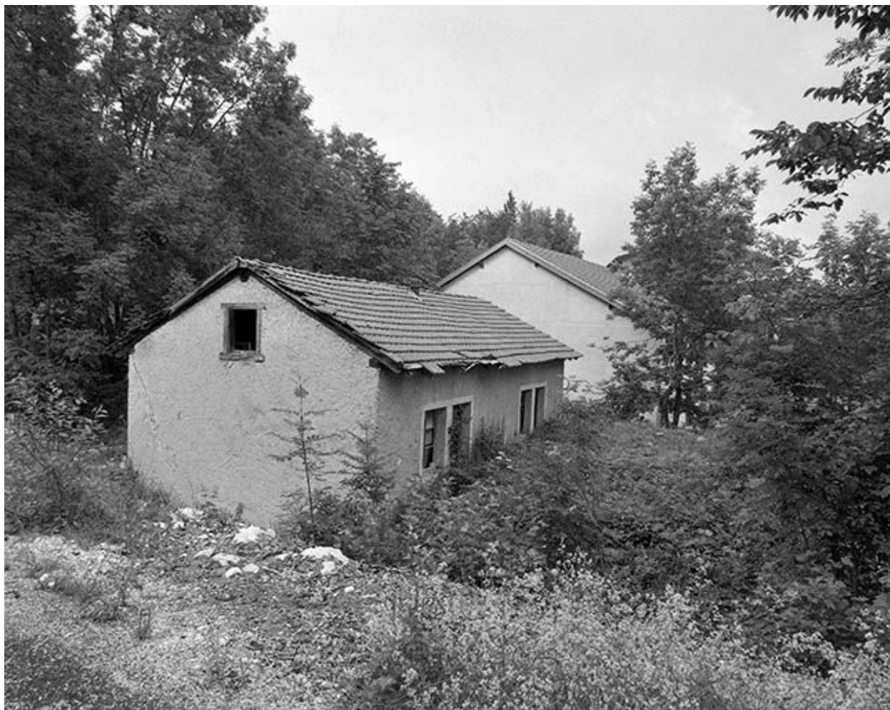
Remise abritant une forge.
