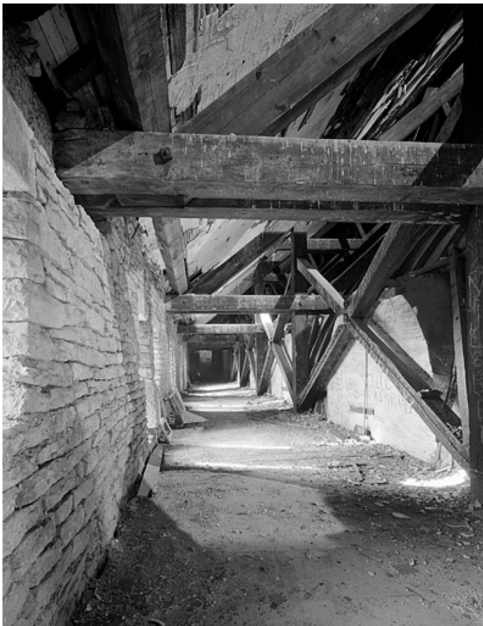
Charpente au-dessus de la tribune droite.
