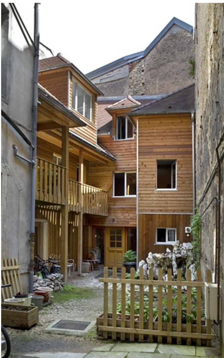
Logis secondaire : vue d'ensemble.
