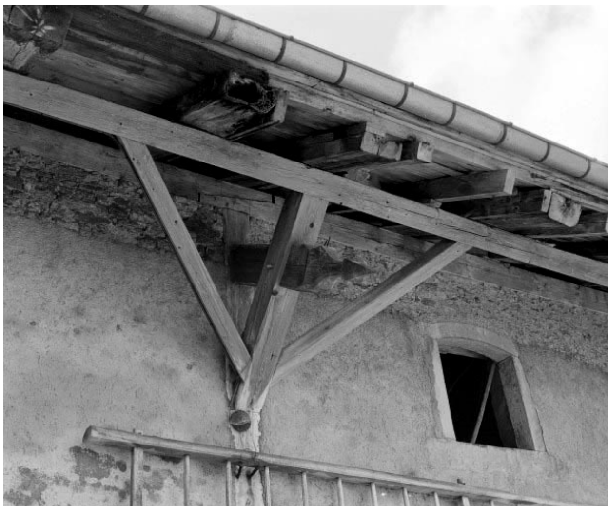
Détail: extrémité d'arbalétrier et assemblage de charpente.
