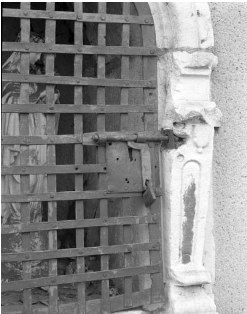
Détail d'une niche sur la façade latérale droite : système de fermeture.
