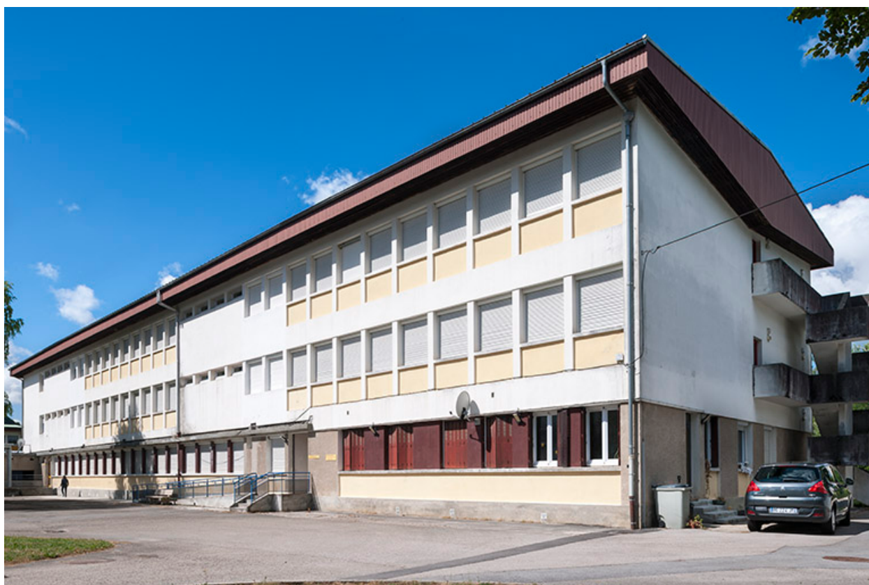
Internat : façade antérieure.
