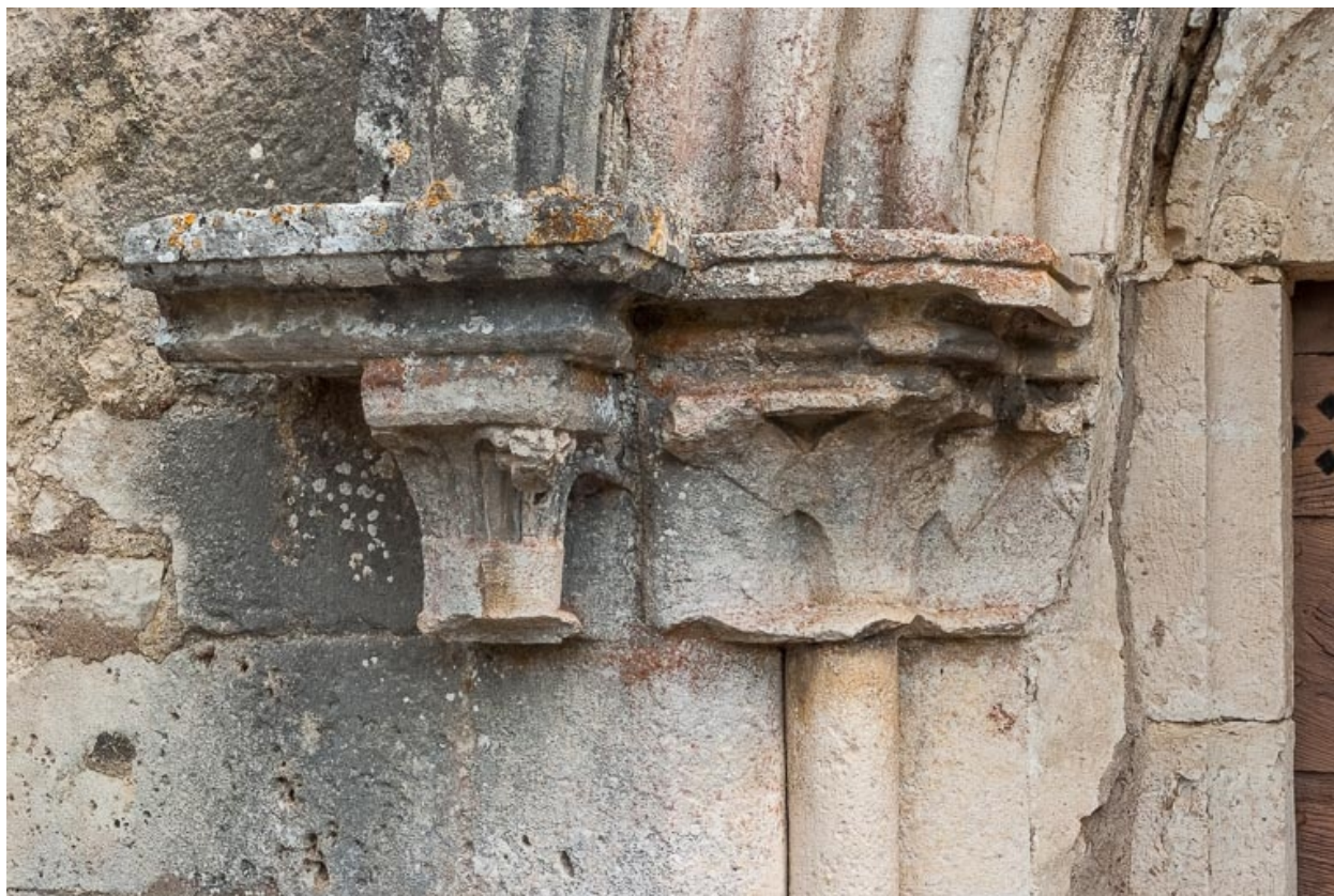
Portail, détail des chapiteaux.
