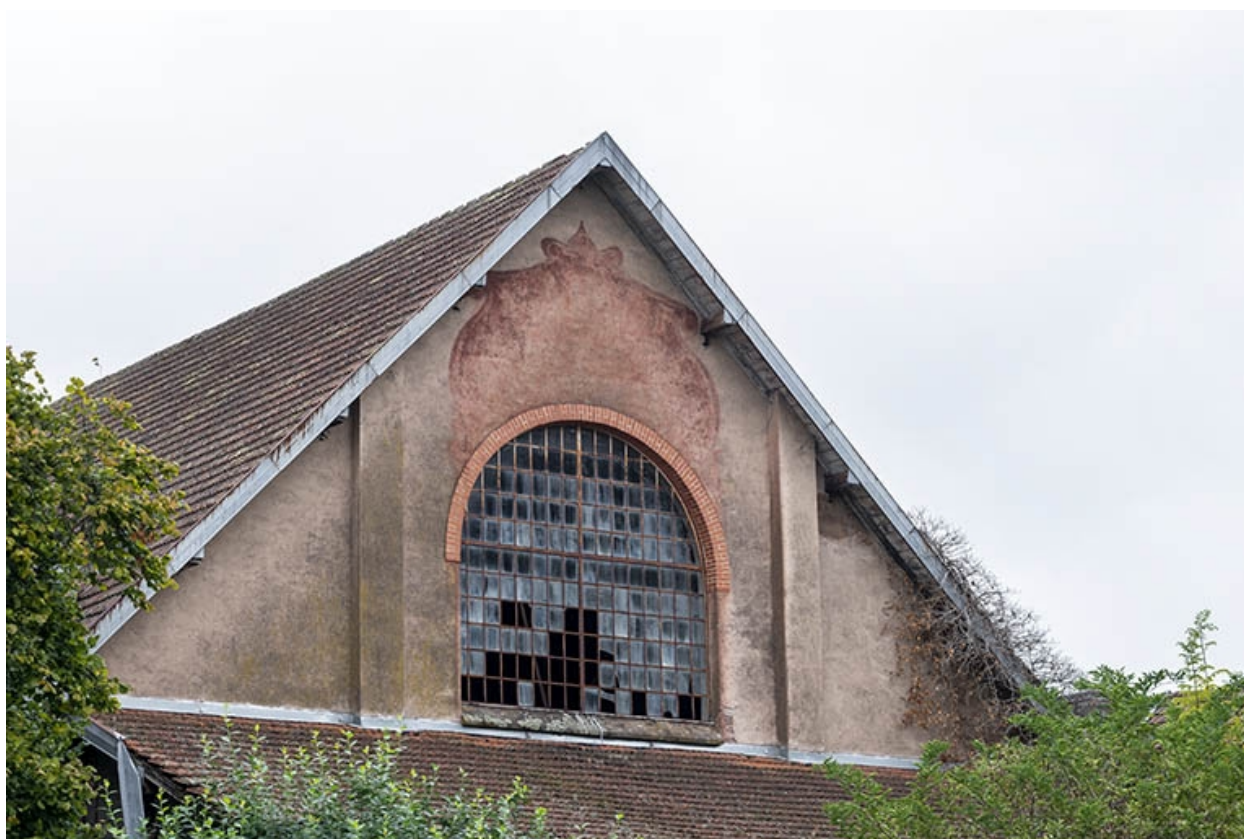
Mur-pignon sud, baie du pignon.
