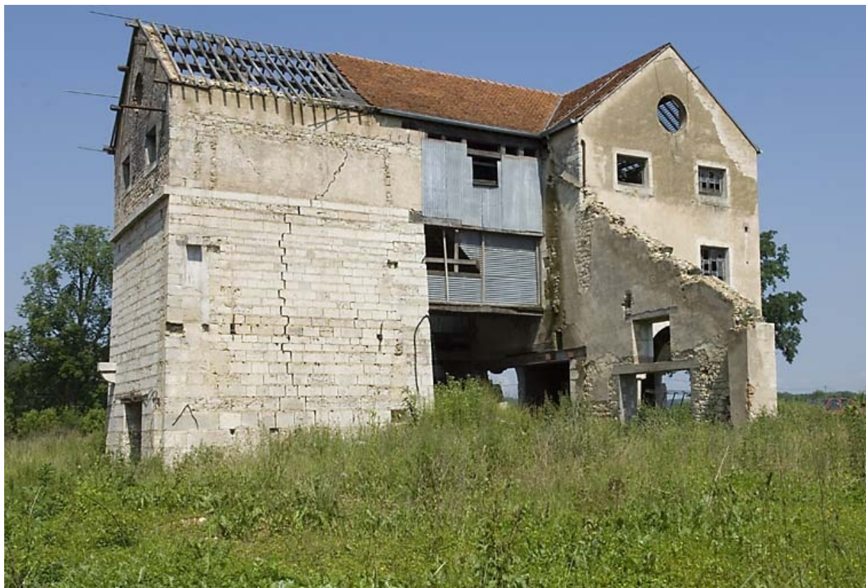
Vue depuis le sud-ouest.
