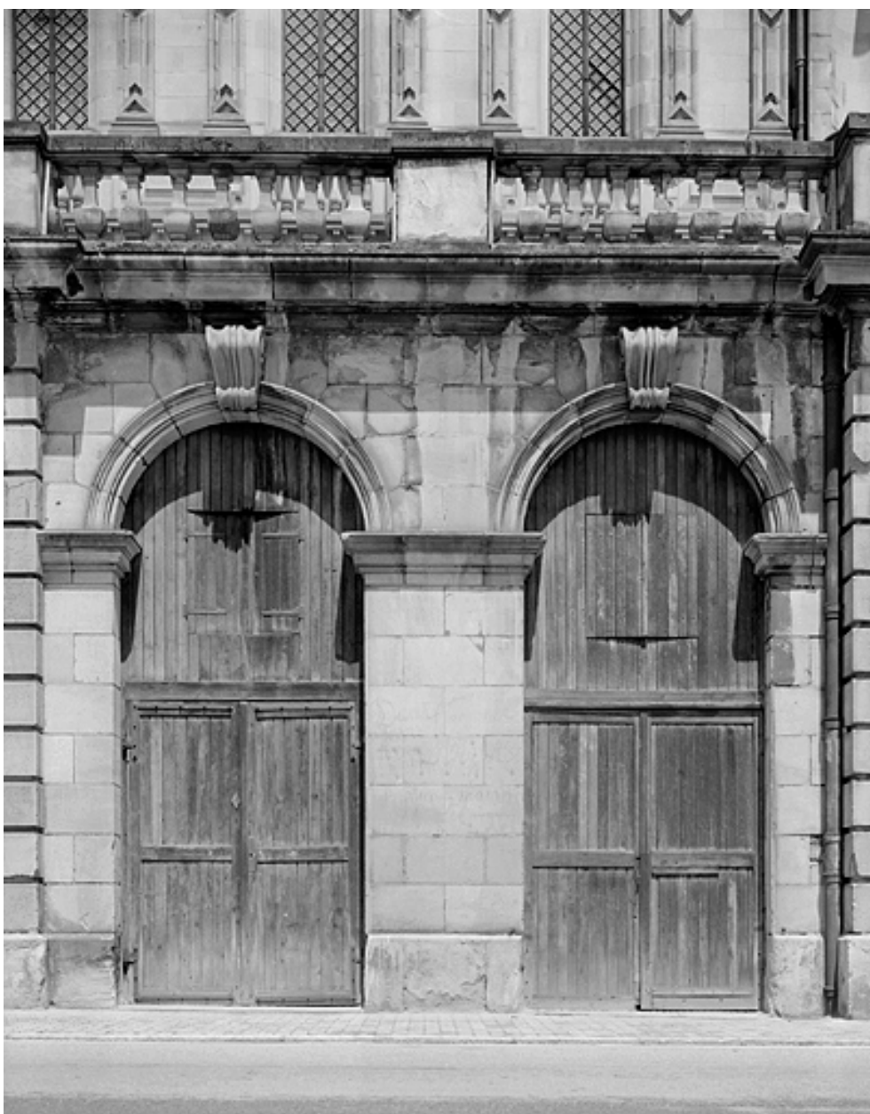
Baies des boutiques.
