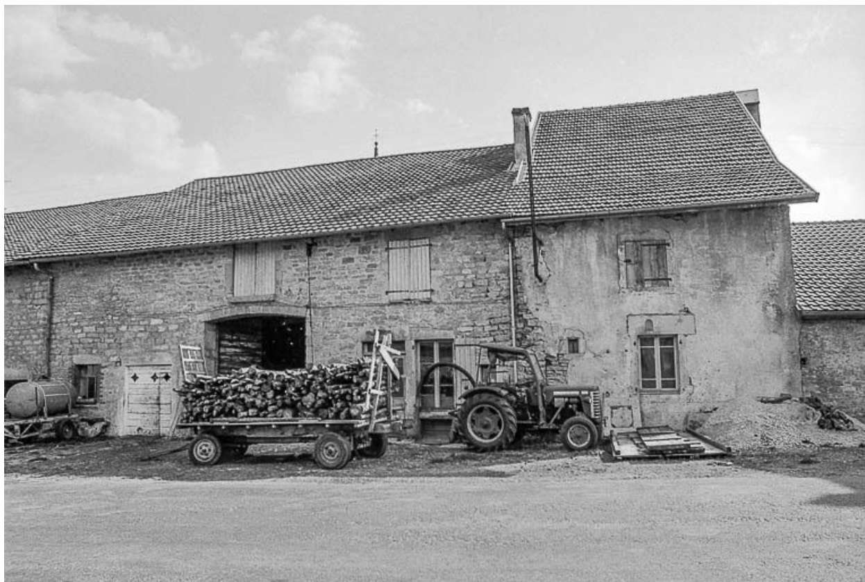
Ferme cadastrée A3 194 : façade antérieure.
