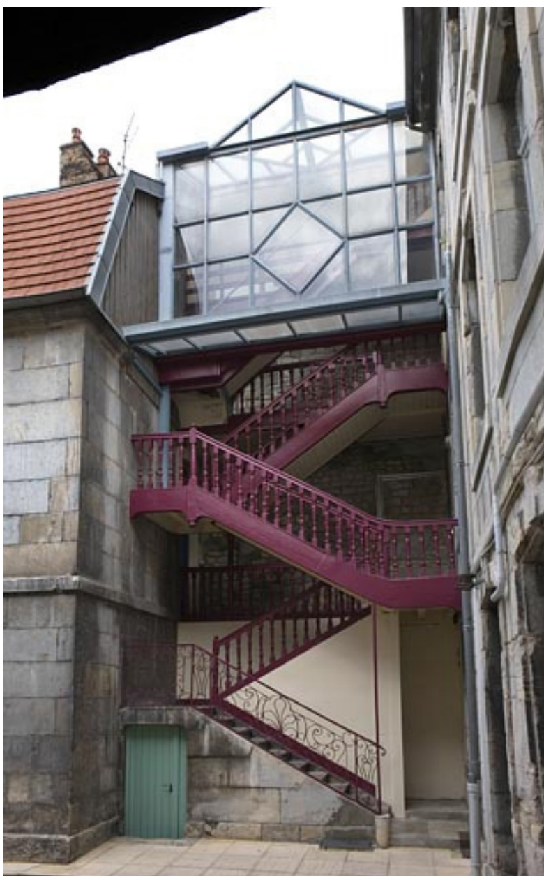
Vue d'ensemble de l'escalier à cage ouverte.
