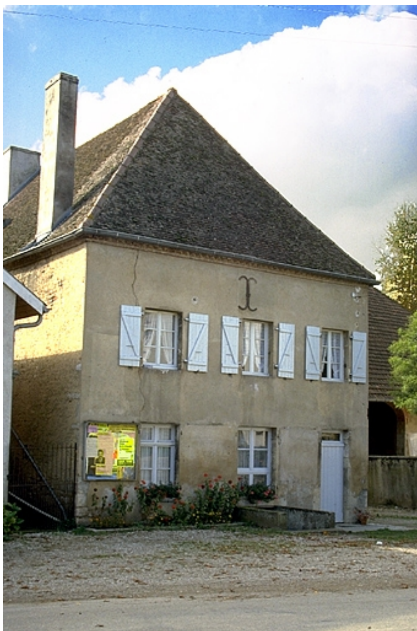
Façade antérieure, vue de trois quarts gauche.
