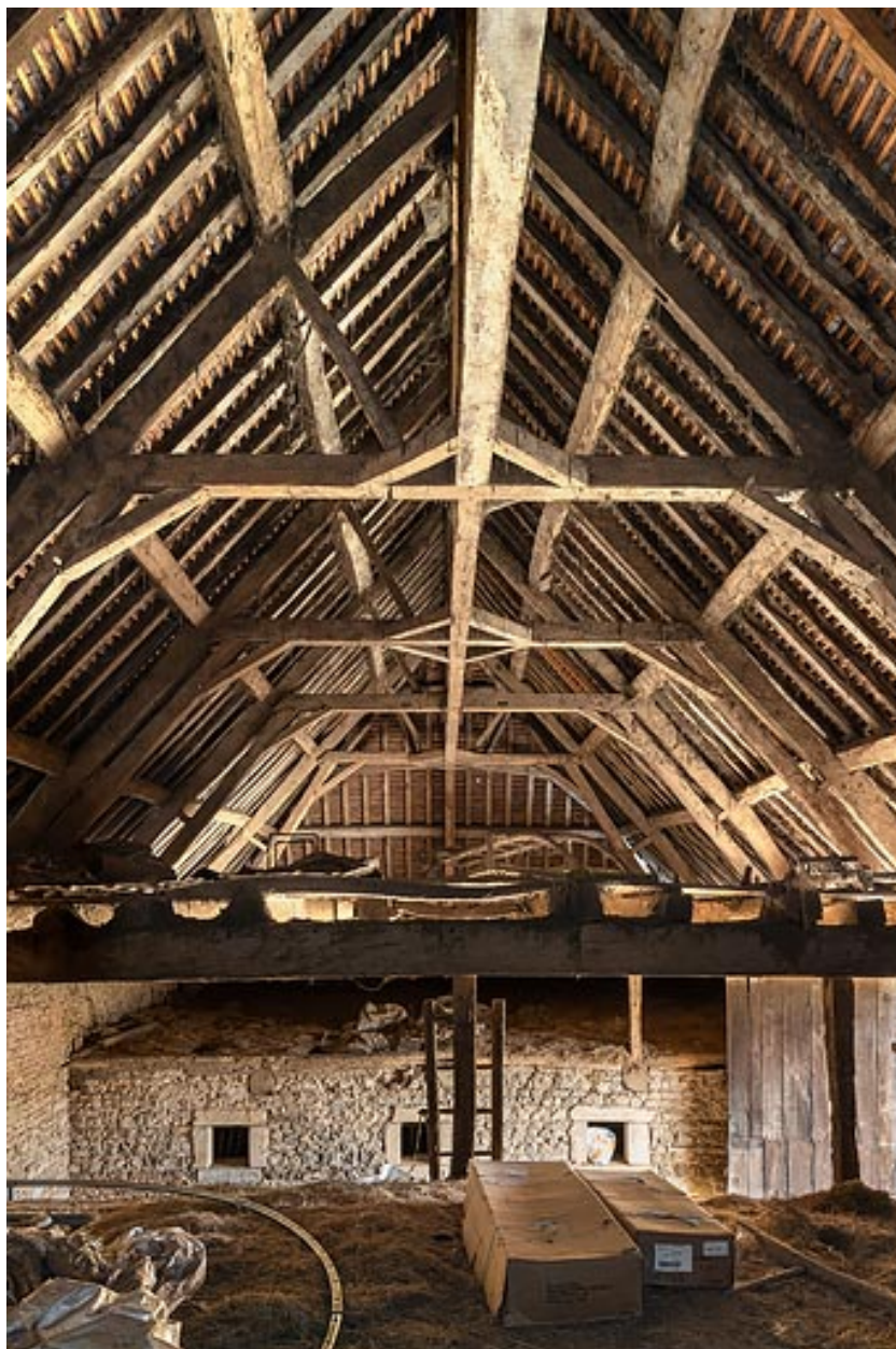
Charpente et fenil de la grange
