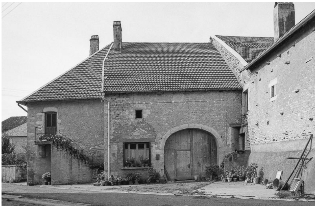
Façade antérieure vue de face.
