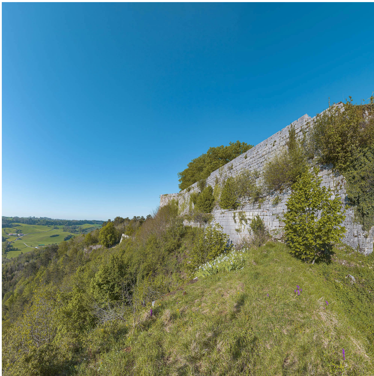
Rempart du front est.
