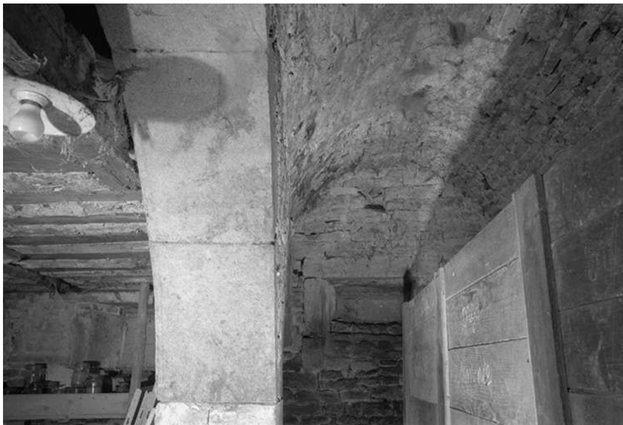
Intérieur : voûte de la cave.
