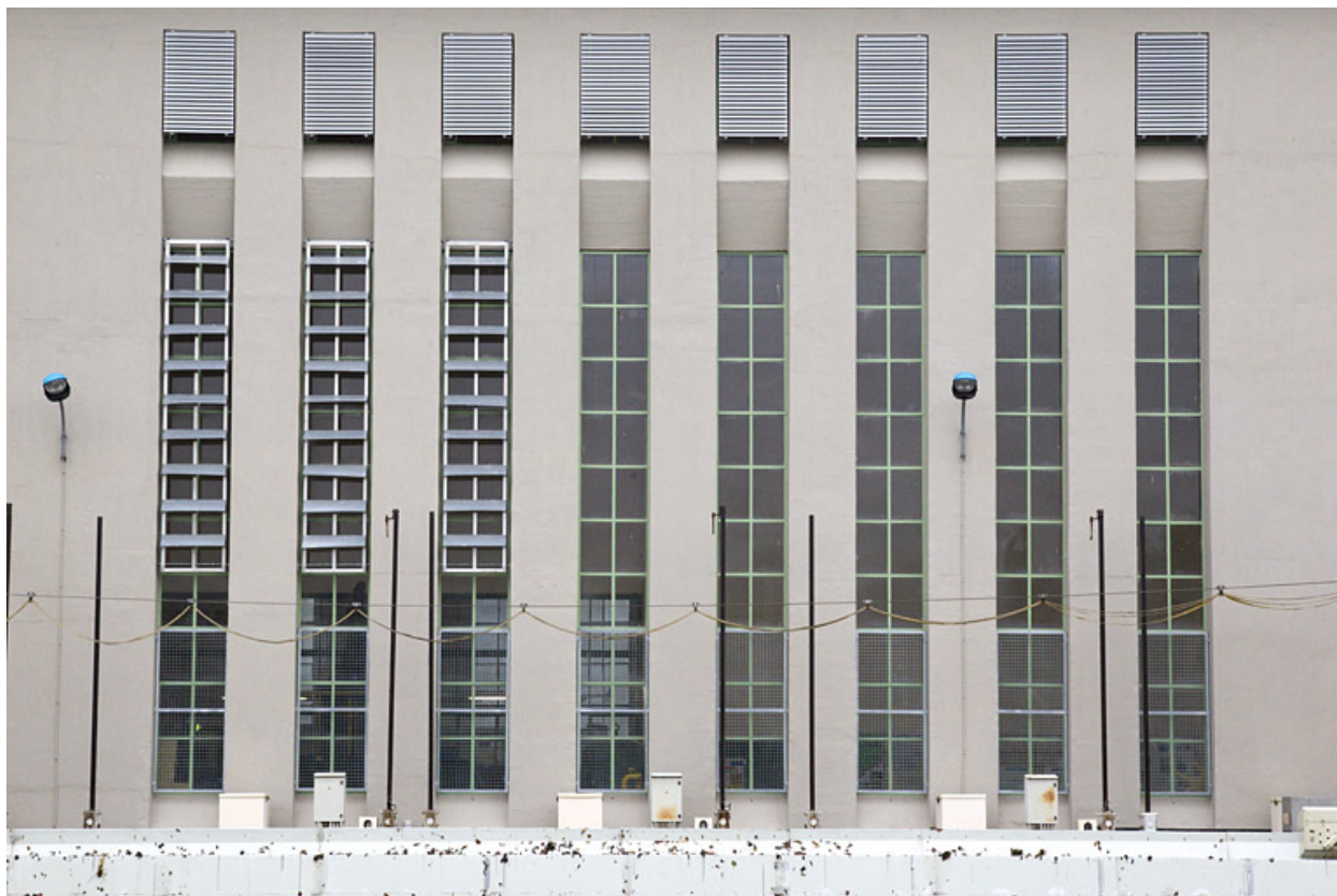
Détail des baies de la façade sud.
