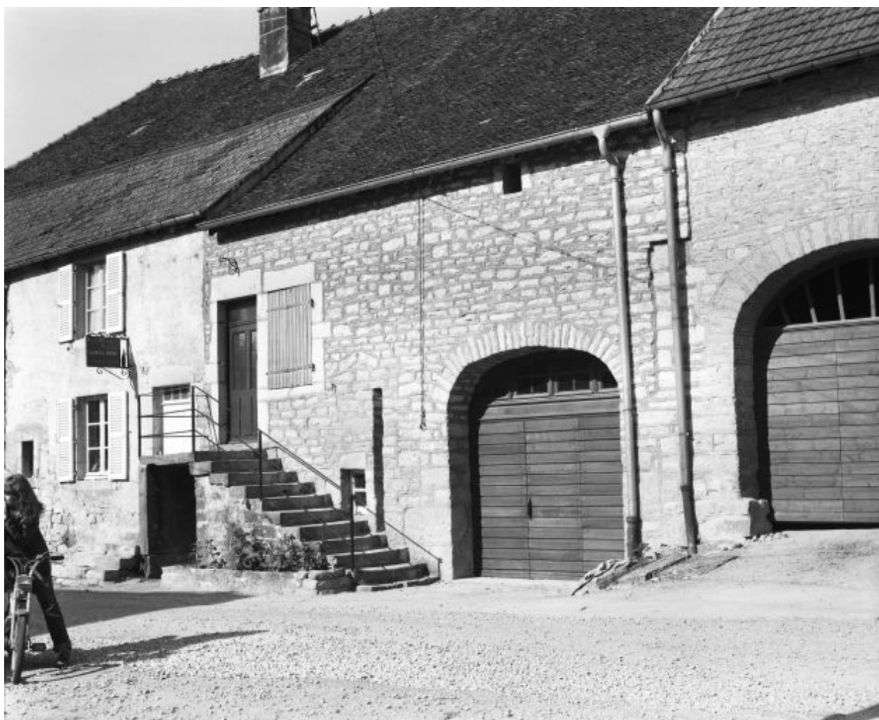
Ferme située au lieudit Billin : façade antérieure.
