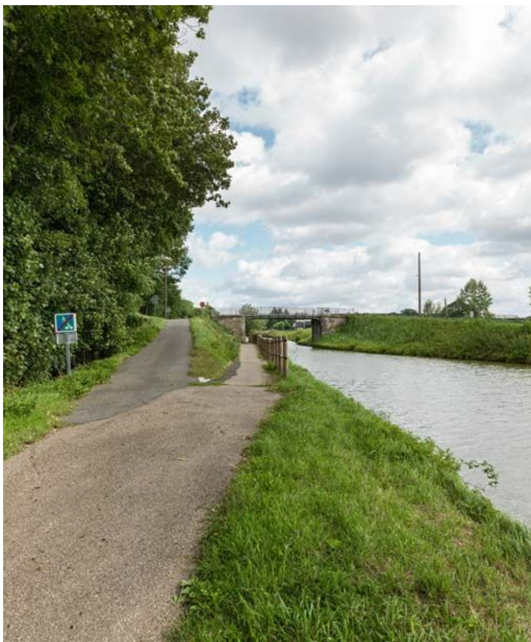
Vue d'ensemble du pont.
