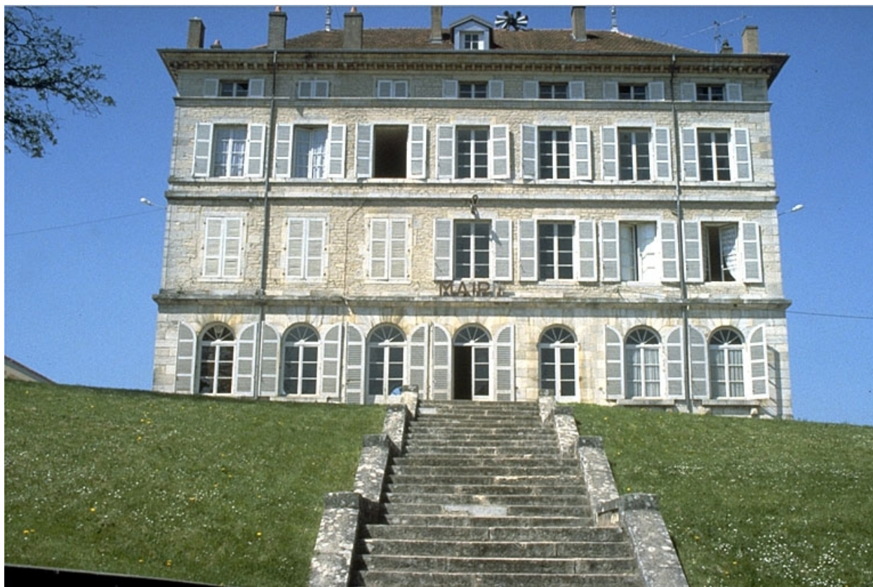
Façade antérieure du logement patronal.
