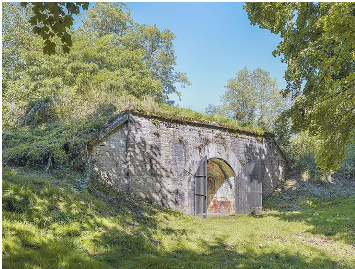
Traverse-abri dite la chapelle.
