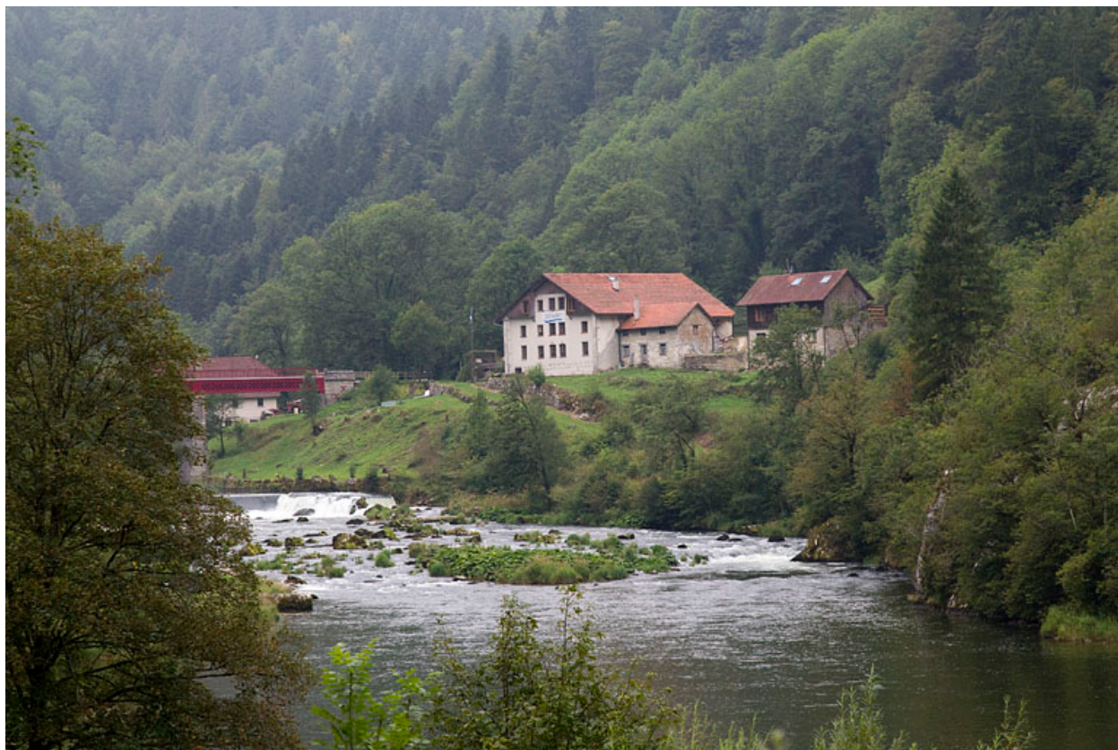
Vue d'ensemble du site depuis l'aval.
