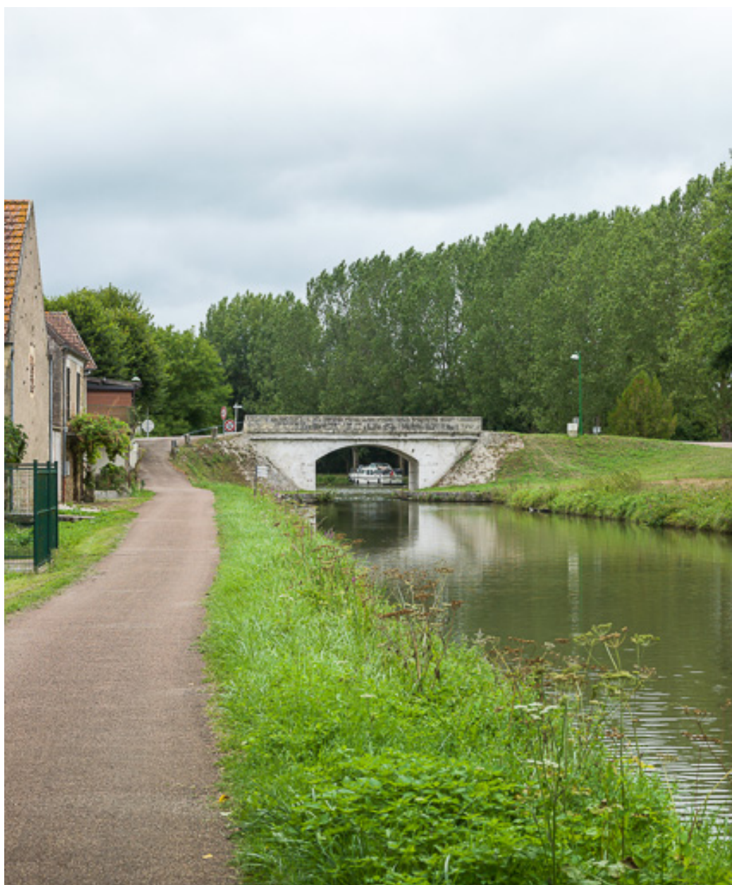
Vue d'ensemble du site et du pont.
