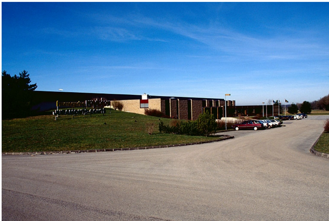
Chaufferie, quai d'expédition et bureaux depuis l'entrée.
