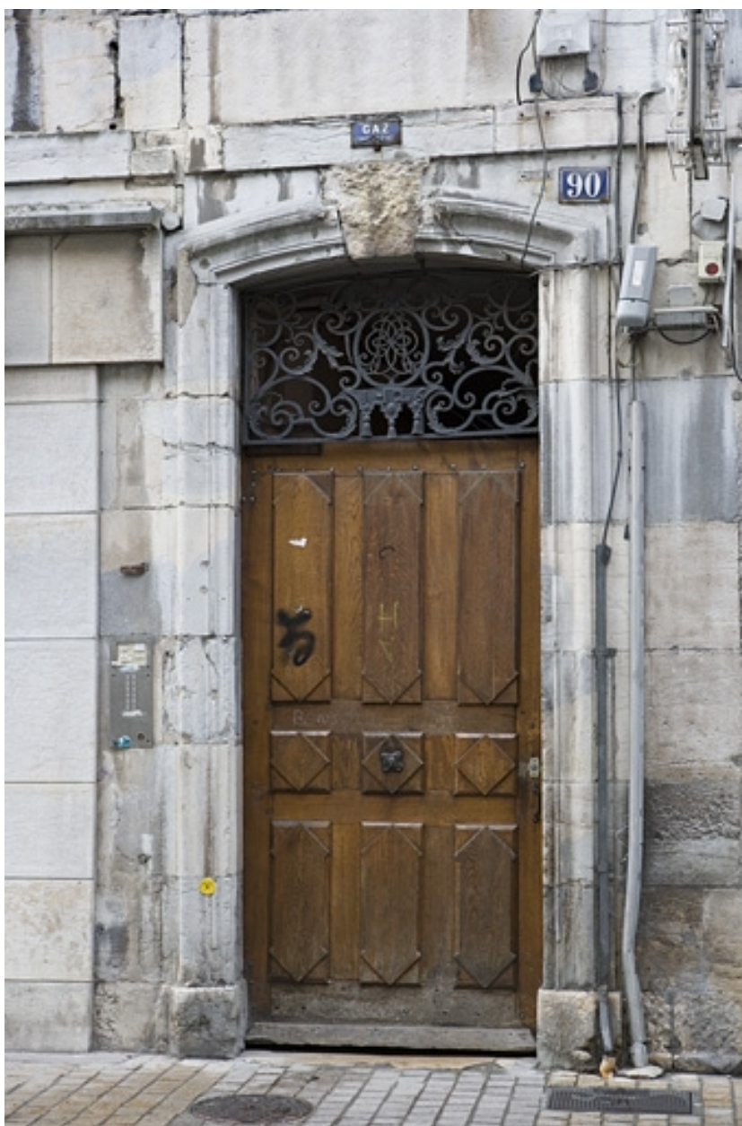
Détail de la porte du couloir d'entrée.
