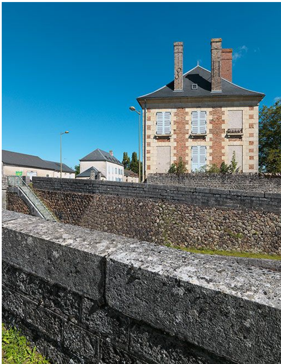
Façade latérale sud.
