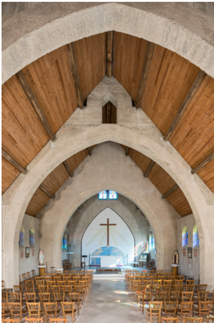
Nef, vue en direction du chœur.
