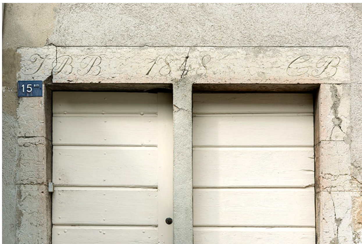
Maison côté cour : linteau daté 1848.
