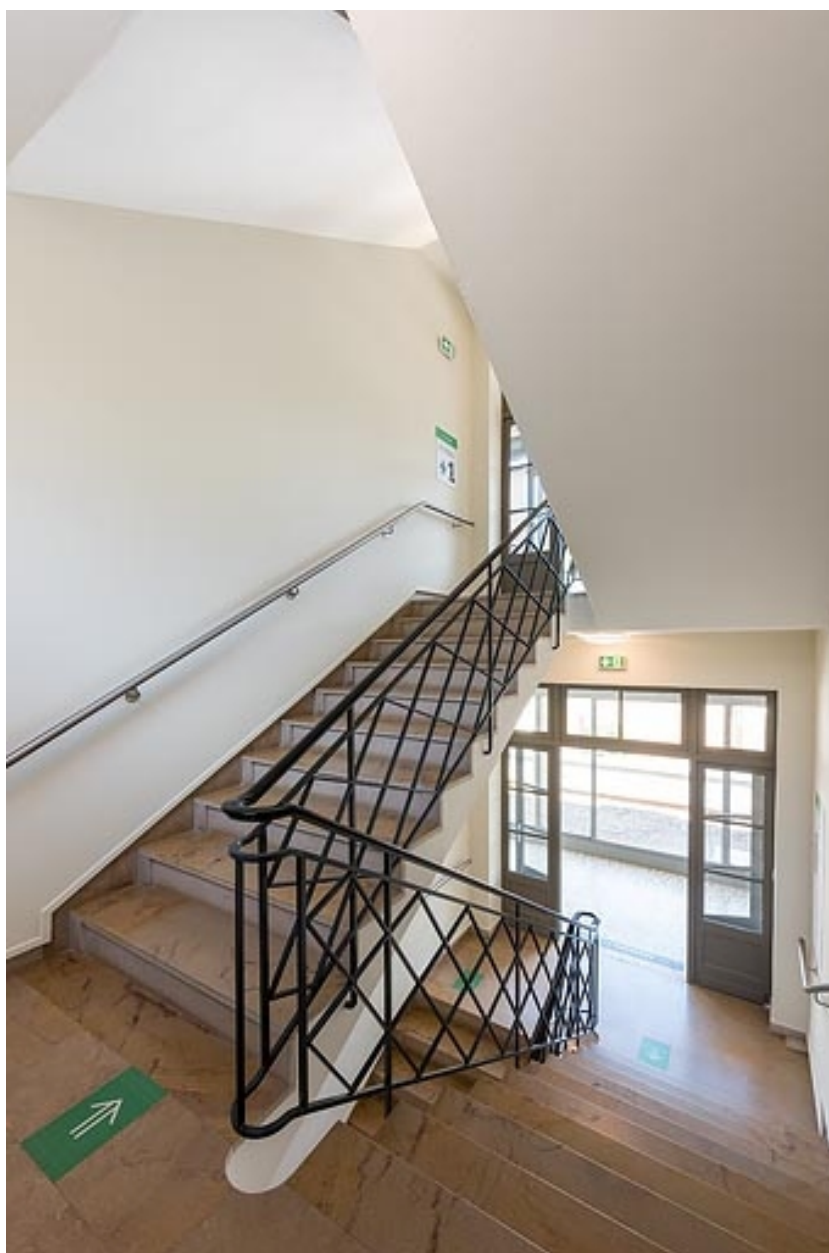
Escalier de l'aile ouest.
