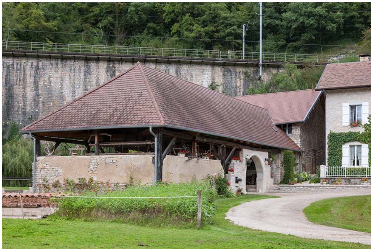
Bâtiment des dépendances depuis le sud-est.
