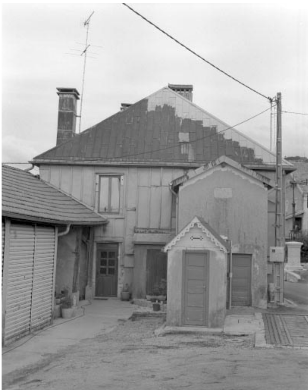
Face latérale gauche couverte d'un essentage en feuilles de zinc.
