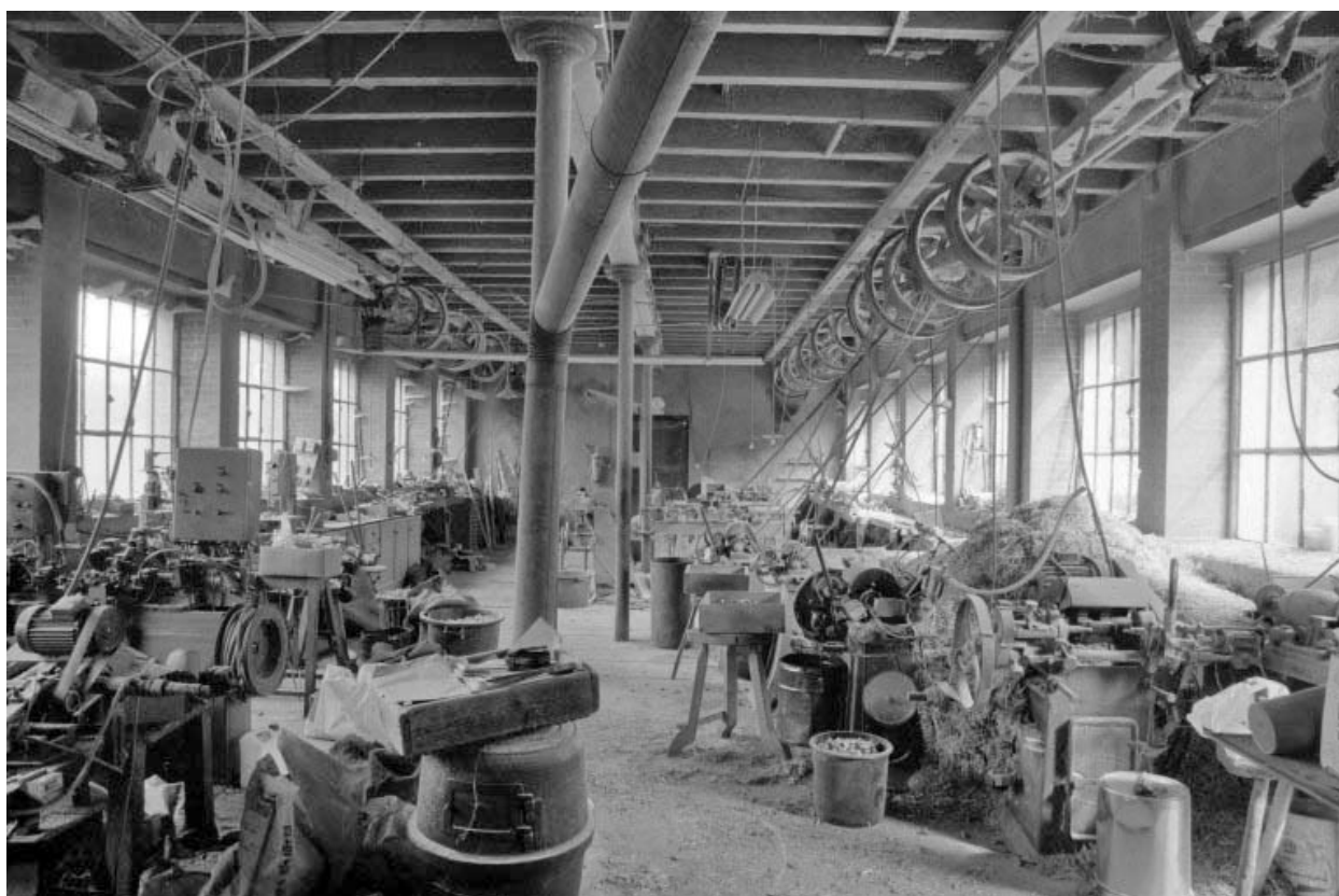
Intérieur de l'atelier de fabrication.
