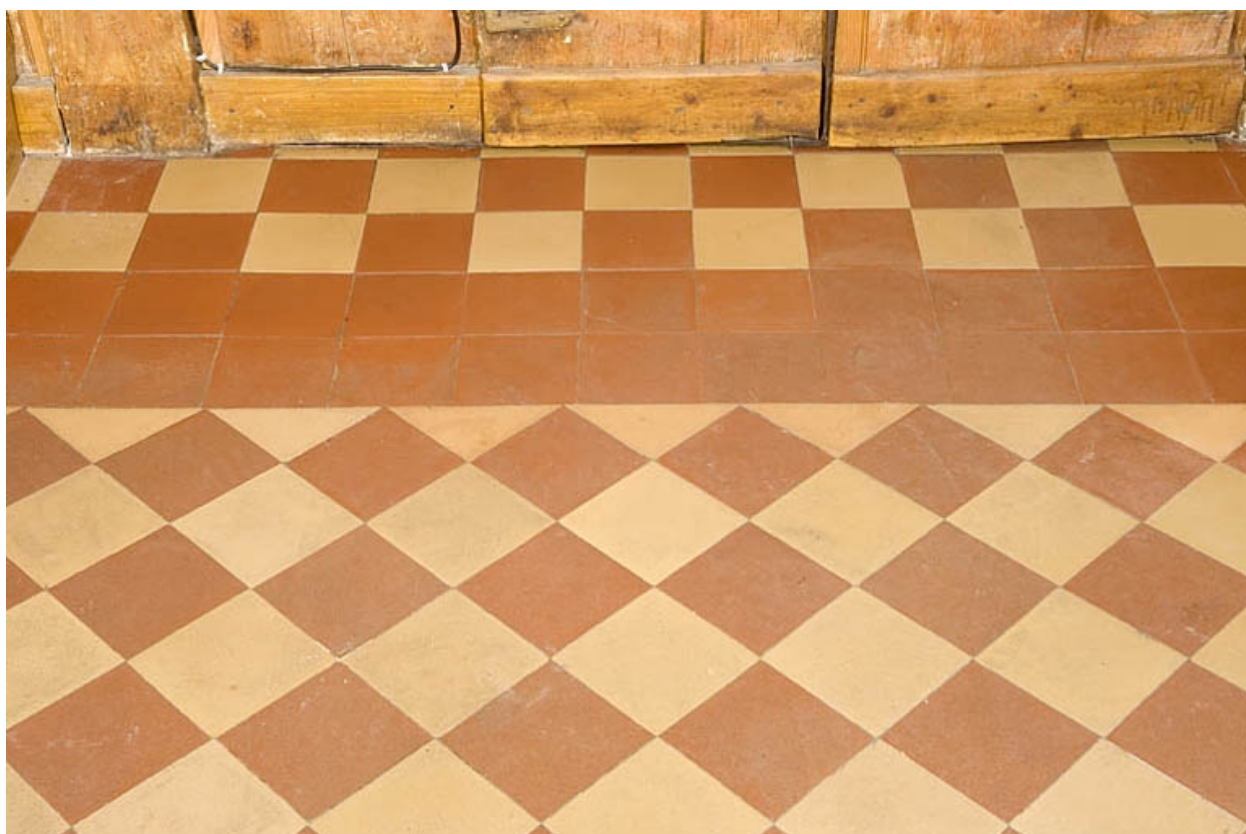
Cuisine du rez-de-chaussée : carreaux au sol.
