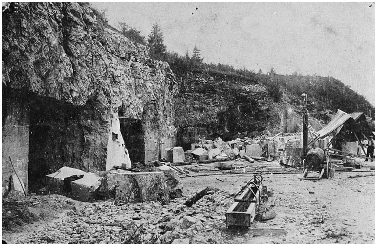
Chantier et entrées de la carrière souterraine.
