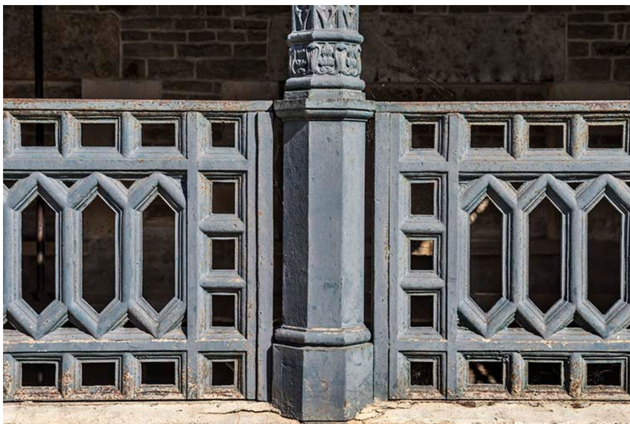
Détail du garde-corps et d'une colonne.
