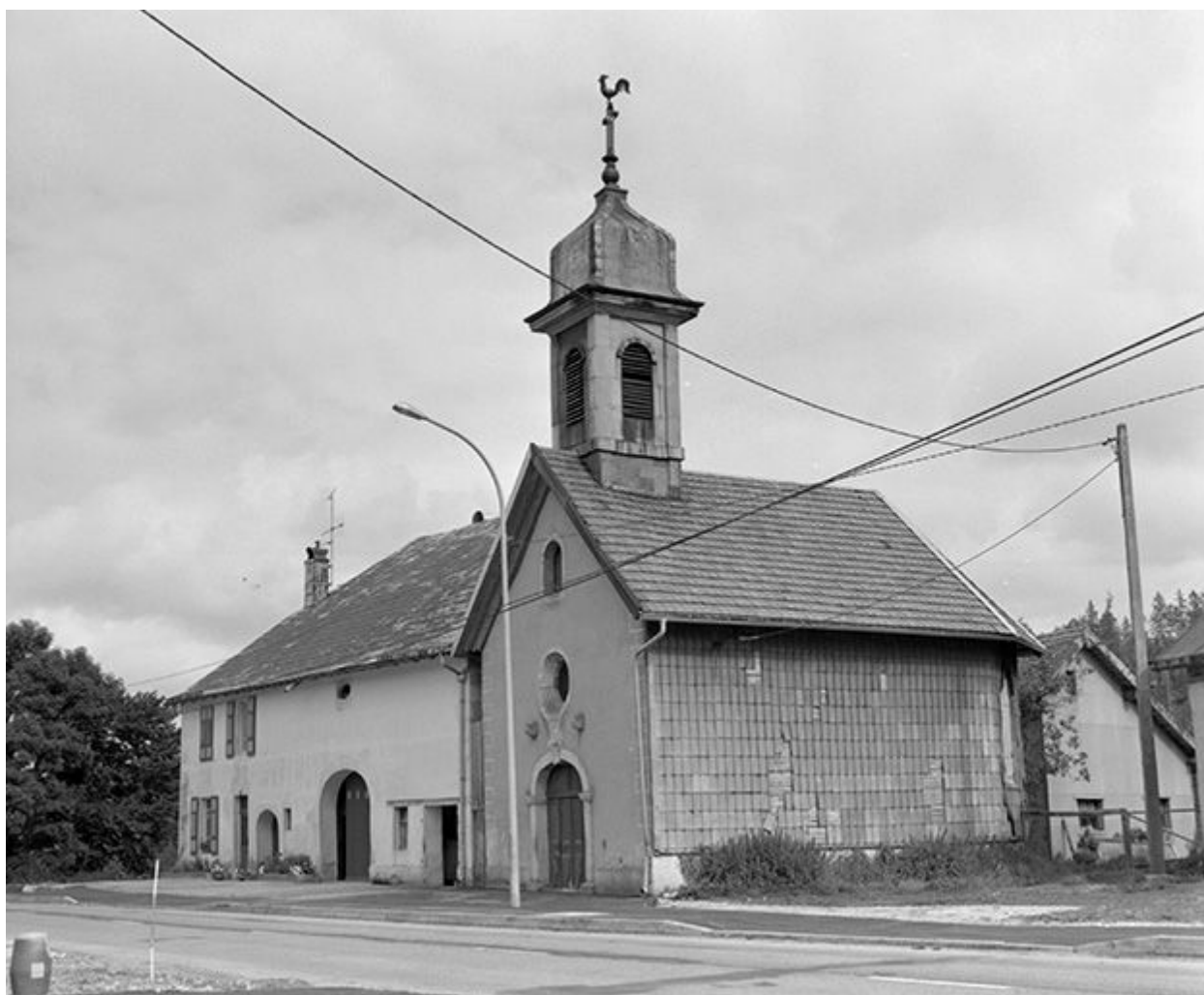
Façades antérieure et latérale droite.
