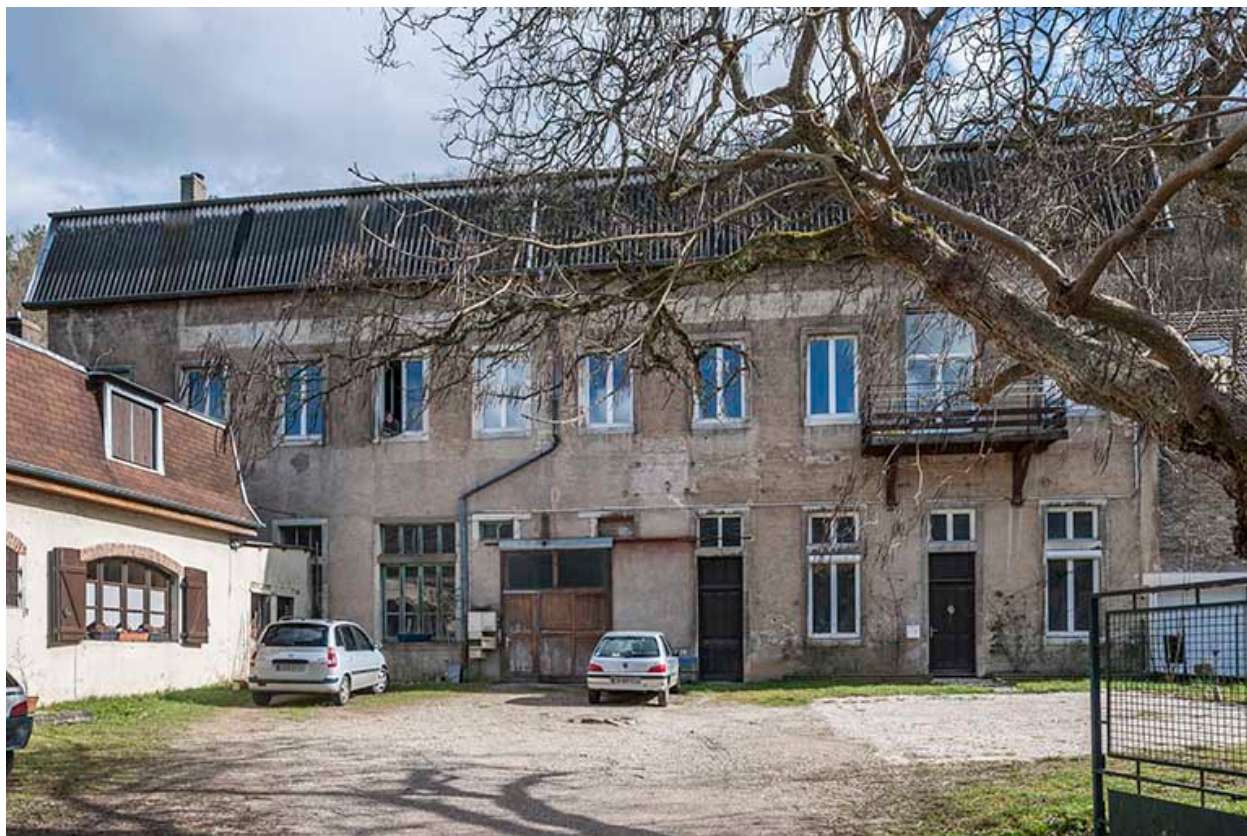
Façade antérieure de l'atelier de fabrication.
