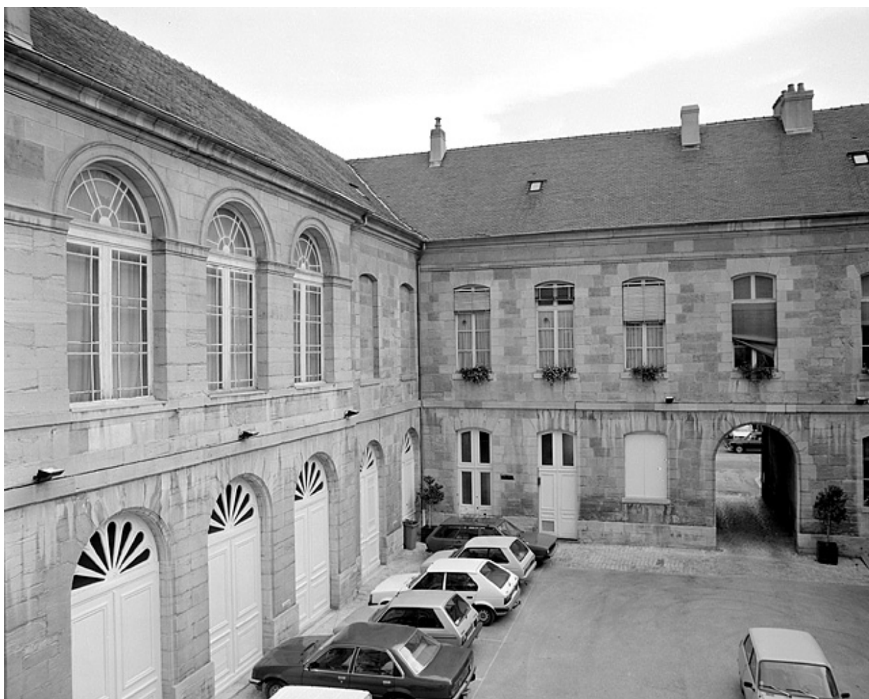
Cour intérieure : côtés nord et est.
